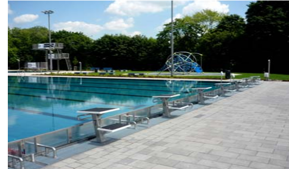
Sportbecken Wasserfläche 1.057 m 2 (50 x 21 m)
